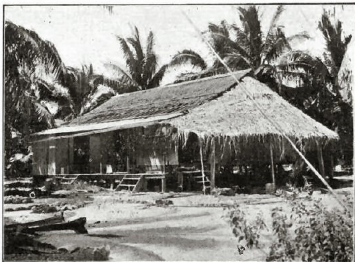
Maison du Gérant. Camp Nord.
